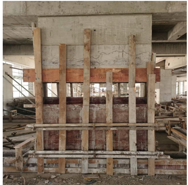
D) 下墙墩施工
