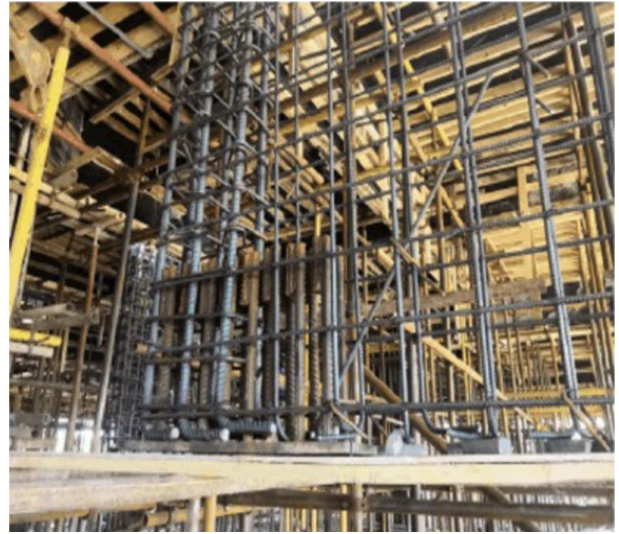
B) 墙墩钢筋绑扎
