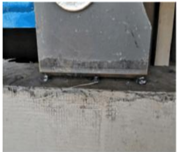
B) 临时焊接
