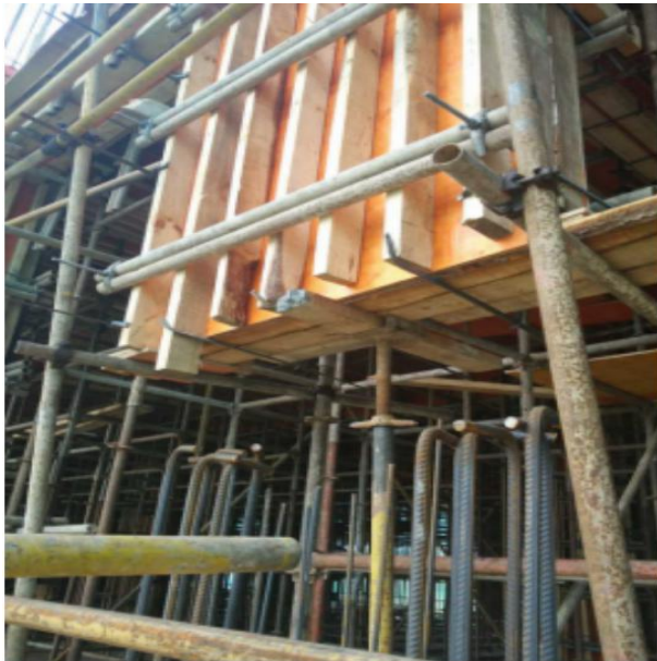
C) 墙墩模板安装
